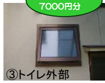
③トイレ外部 ルーバー窓から滑り出し窓に取替♪
